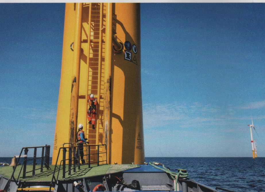
Les éoliennes de Saint-Nazaire sont « monopieux ». Elles sont directement fixées au fond de l'eau.
